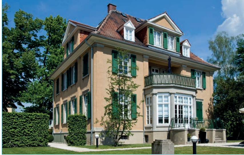
Für die Putz- und Stuckarbeiten an der Villa Hero in Groß-Gerau wurde die Firma Steuernagel & Lampert GmbH & Co. KG mit dem „Bundespreis für Handwerk in der Denkmalpflege“ ausgezeichnet.
