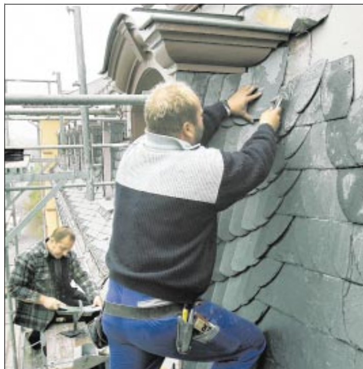
Dach und Mansarden des Darmstädter Regierungspräsidiums haben Handwerker aus Thüringen mit neuen Schieferziegeln versehen. 300 000 Euro hat es gekostet, das stark angegriffene Dach des Verwaltungsgebäudes komplett zu erneuern. FOTO: KARL-HEINZ BÄRTL
